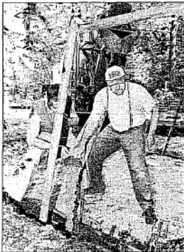
BAUARBEITEN: Reck und Schaukeln werden einbetoniert.
